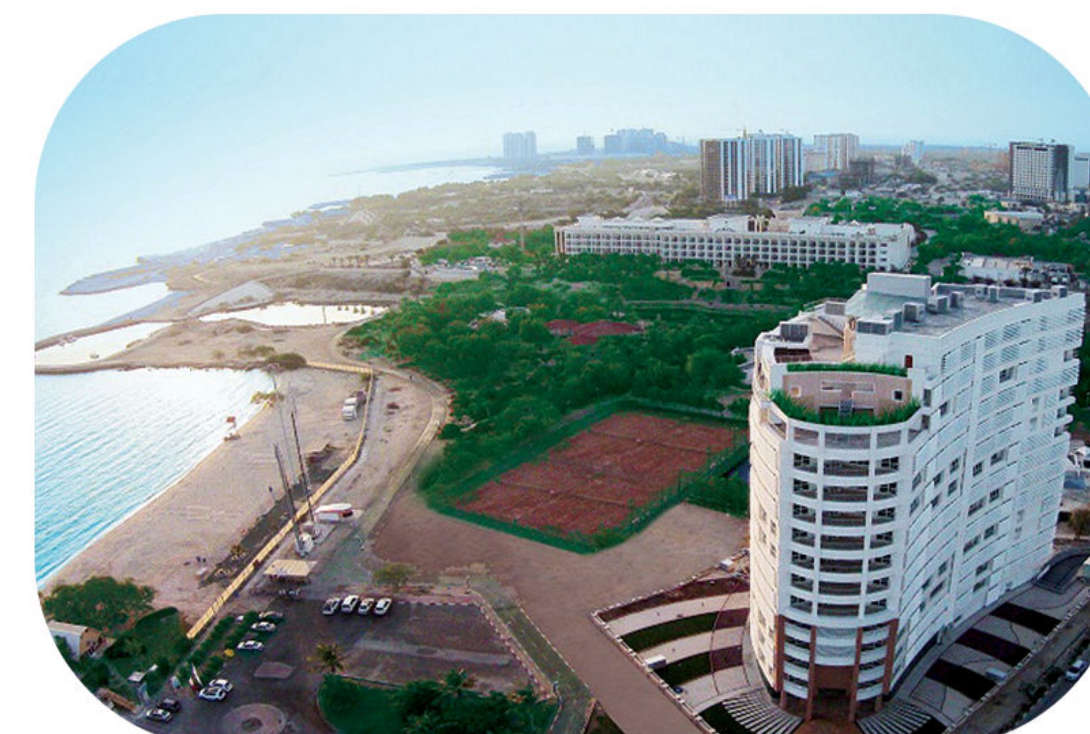
■ پروژه اقامتی الکترو استیل محل پروژه: کیش
