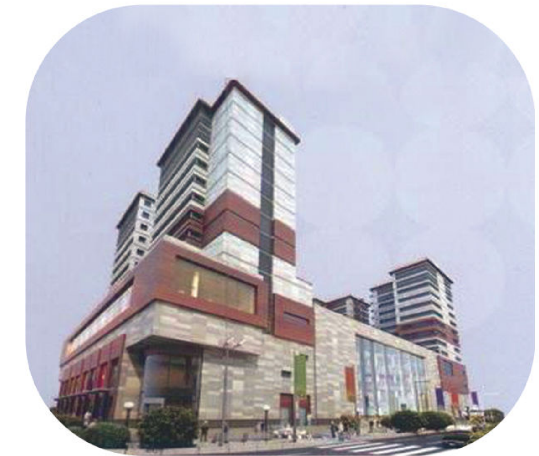
■ مجتمع اداری و تجاری خیام محل پروژه: تهران (منطقه ۲۲)
